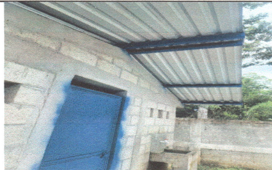
Foto 2: Mantenimiento de puerta.
