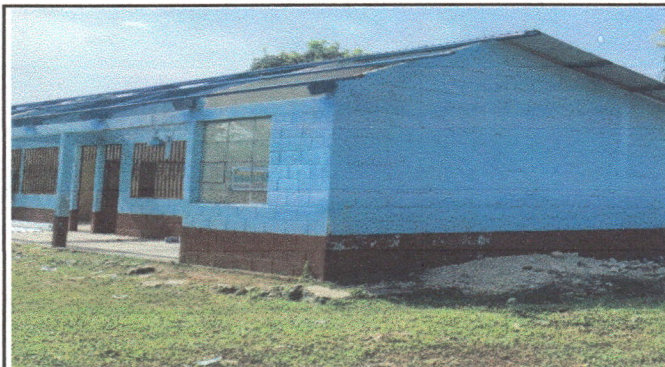
Foto 3: Cambio de costanera.
