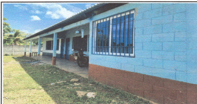
Foto 5: Instalacion de ventanas pvc.
