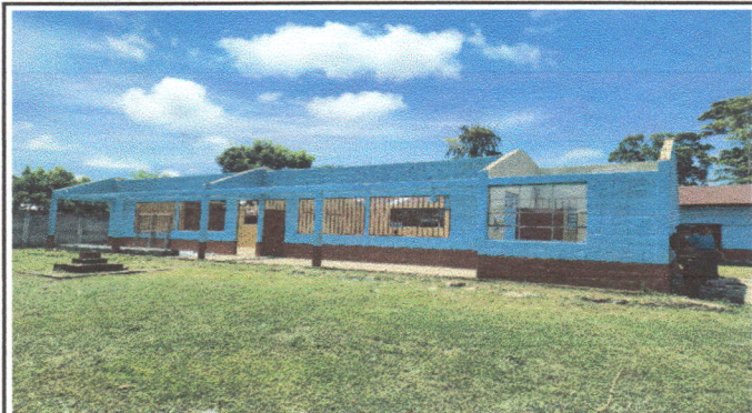
Foto 1: Cambio de láminas por deterioro.
