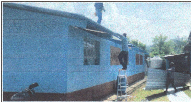
Foto 6: Instalacion de lamina troquelada.
