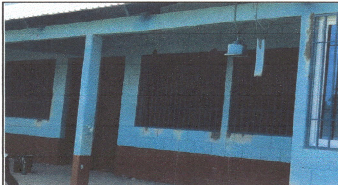
Foto 4: Mantenimiento de balcon.
